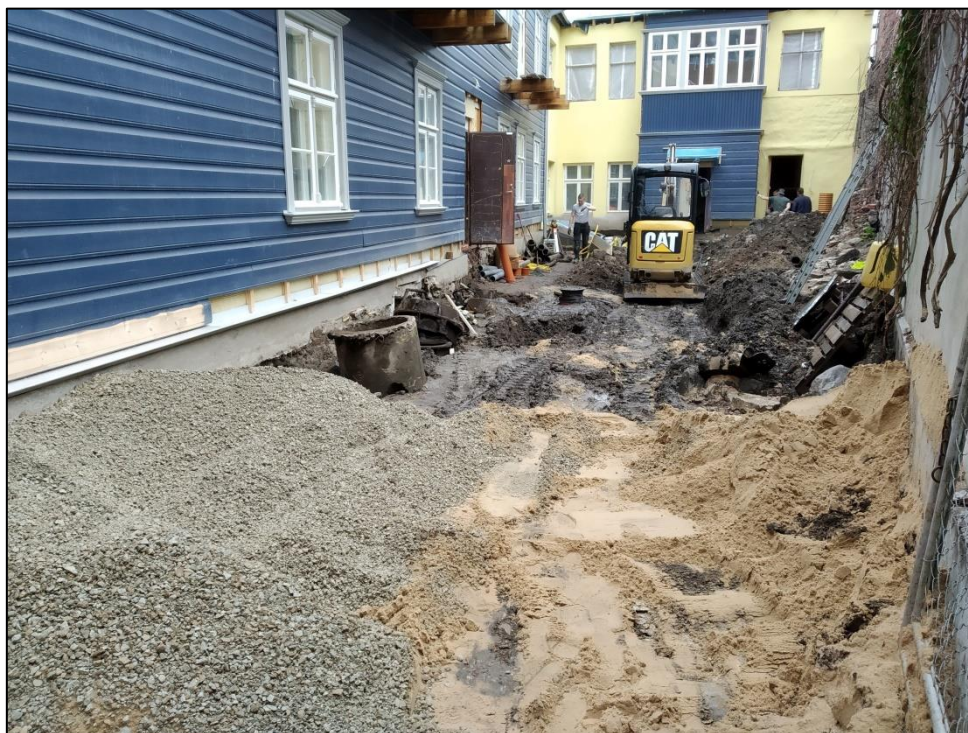
1. Hommiku tänav 5. Vaade lääneedelapoolse kraavi kaevamisele põhja poolt.
